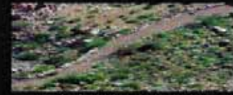
إعادة تخطيط الدرب على نفس نمطه القديم في الأماكن التي تم ترميمها
