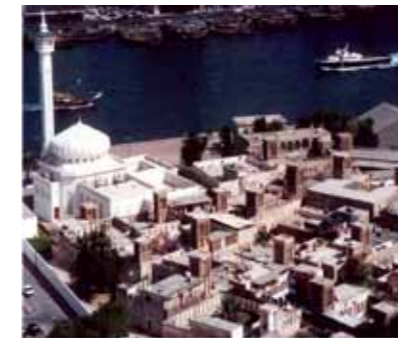
حي الفهيد قبل الترميم
