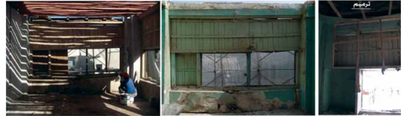
ترميم الألواح الخشبية الداخلية وتبديل النافذ
