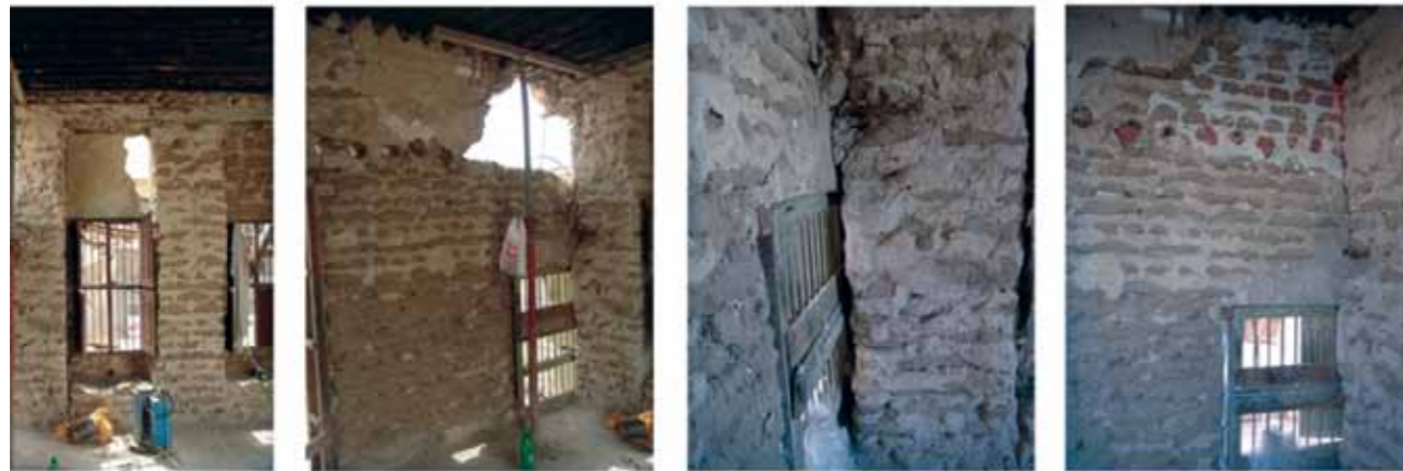
ترميم الجوانب والجندل والأخشاب ومعالجتها وإعادة تكسيته وتبديل النافذ
